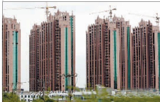
上海一即将完工的住宅楼群。（新华社发）
