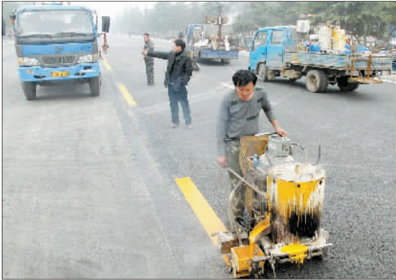
施工人员正在画行车标线。
