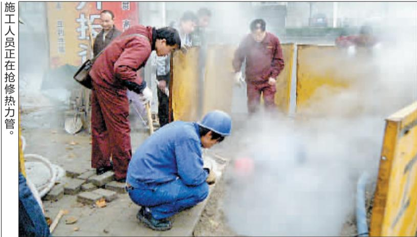
施工人员正在抢修热力管。
