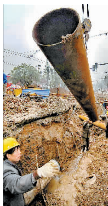
施工人员更换断裂管道。
