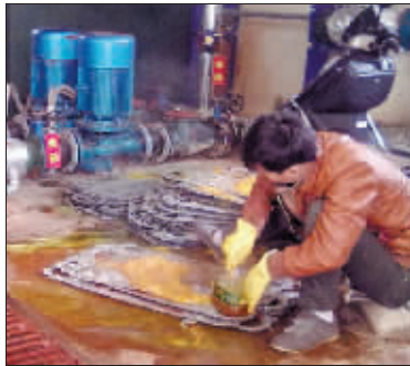
工作人员在清洗换热器。
