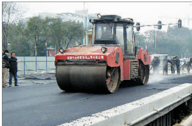
工人摊铺沥青,压路机夯实路面。 见习记者 崔晓彧 摄
