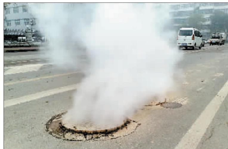
破裂；其二，可能是供水管道破裂，自来水流到供暖管道上受热形成蒸汽；其三，可能是与该供暖管道并行的一处热力公司供暖管道发生破裂。
