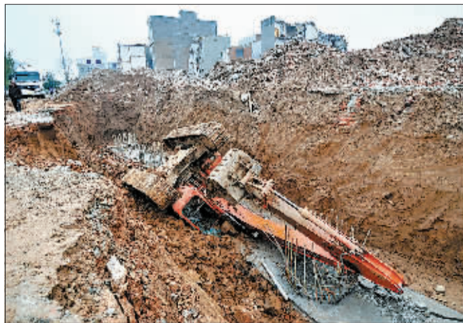
跌入施工沟槽的履带式挖掘机。
