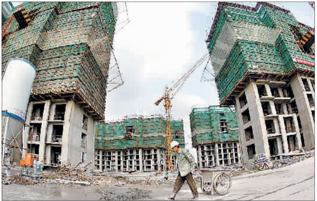
工人在上海闵行区一处在建保障房基地（新华社发）
