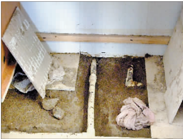
白女士家的地面被挖开,露出暖气管道。
