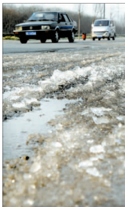
路面结冰的不止面包车出事现场一处。 记者 高山岳 摄于新区博物馆路
