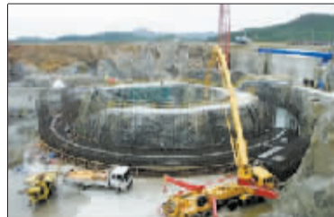
图为2002年8月7日,朝鲜一核反应堆的施工现场。
