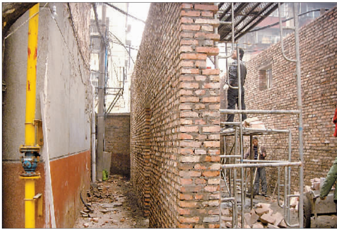
在建的换热站距6号楼仅1米多。
