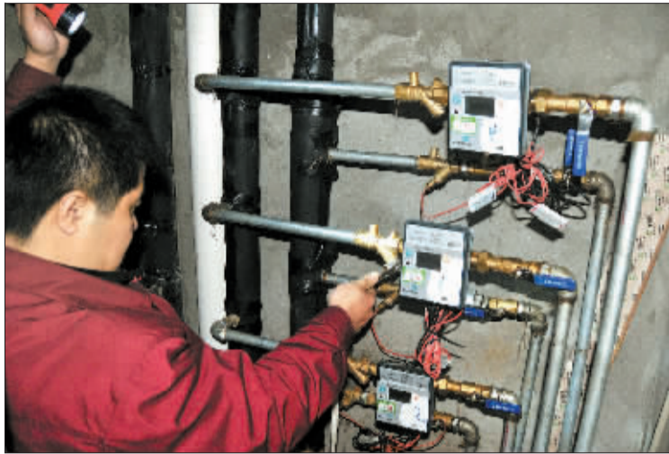
热力公司工作人员为居民检修暖气。
