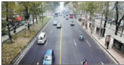
2011年11月17日,中州中路快车道完成提升改造后通车。
