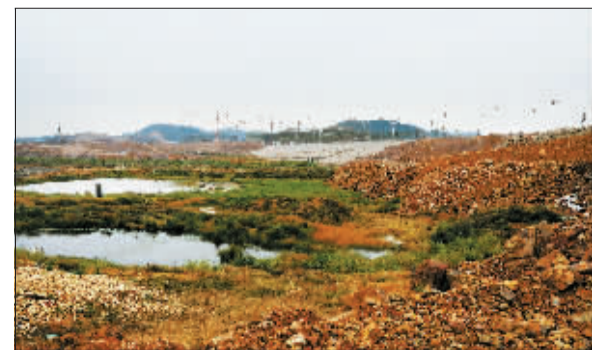
在都昌县滨水西区建设中，施工方将一些山体劈开，用山体石块、泥土甚至是建筑垃圾，填入干涸的鄱阳湖湖床。
