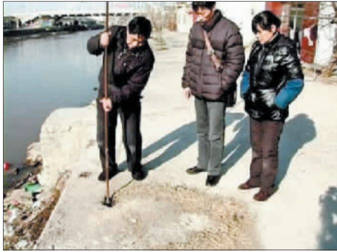
居民在事发地不远处用钢筋凿开路面。(据中新网)
