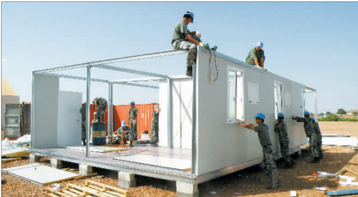
建活动板房。(本版图片均由驻洛某舟桥部队提供)
