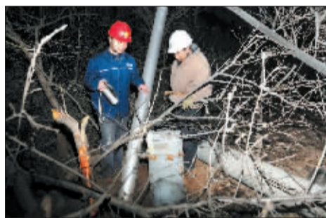
洛阳供电公司工作人员正在抓紧抢修受损线路。
