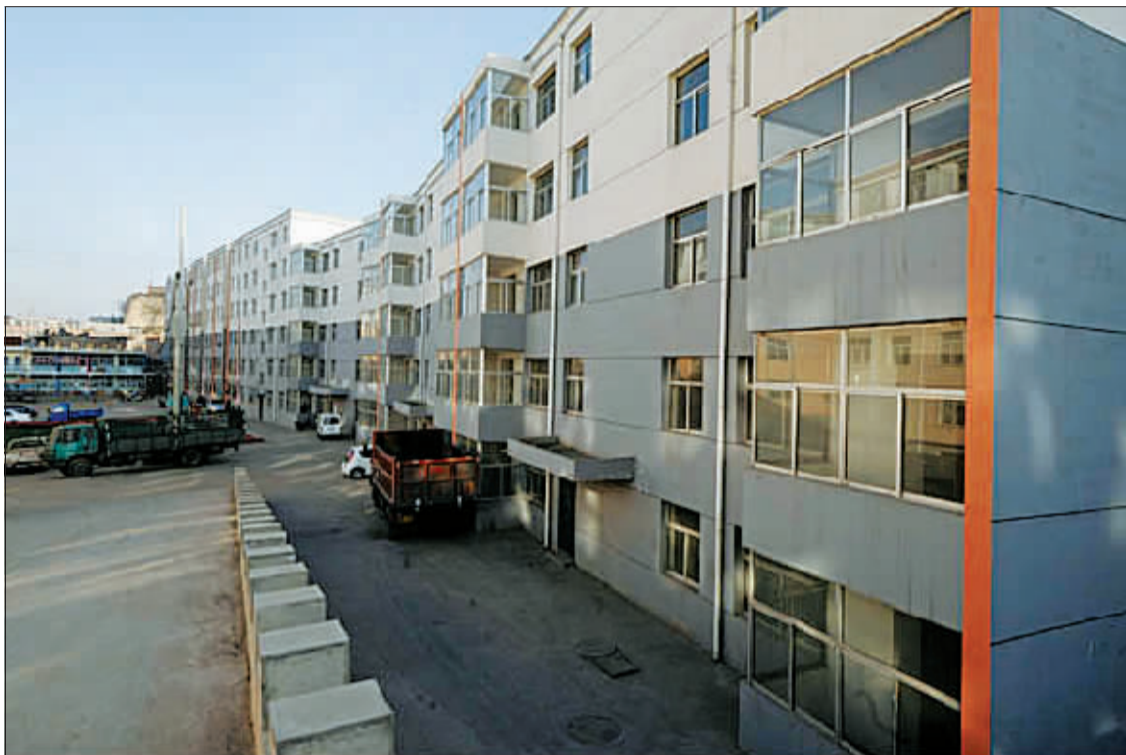
这是兴县福临家园小区内的一栋廉租房。自从2010年6月建成以来，该楼闲置至今，无人入住。新华社记者 范敏达 摄
