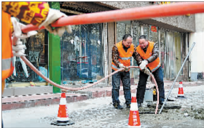
抢修人员全力疏通冒污管道。
