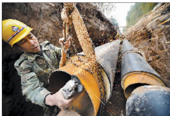
施工人员在铺设暖气管道。 记者 陈占举 摄
