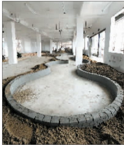
名花展室内展区正在装修。
