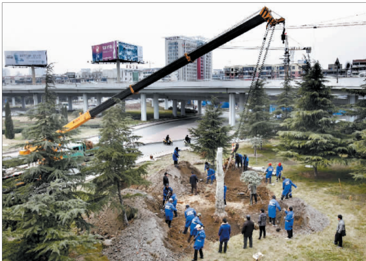
在吊车的帮助下,法桐被安置在定鼎立交桥下面的“新家”。
