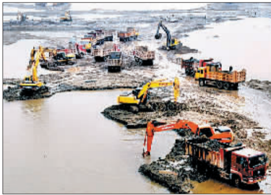
施工单位正在紧张作业。
