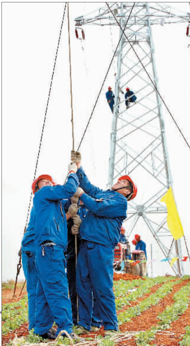
拉升电力设备。
