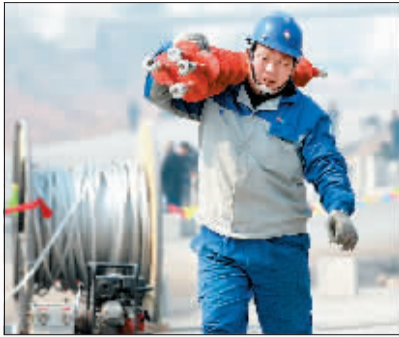
搬运电力设备。
