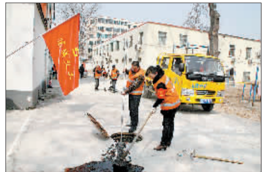
“花城义工”在为洛阳外国语学校疏通下水管道。
