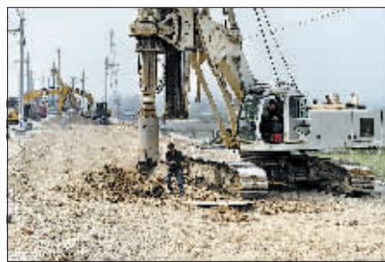
施工机械在对发生沉降的铁路路基进行整改加固。
