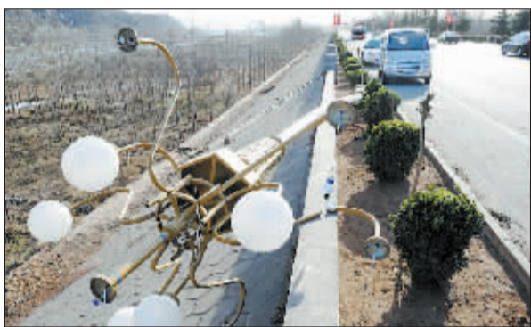
▲ 汝阳县被风刮倒的路灯 记者 高山岳 摄
