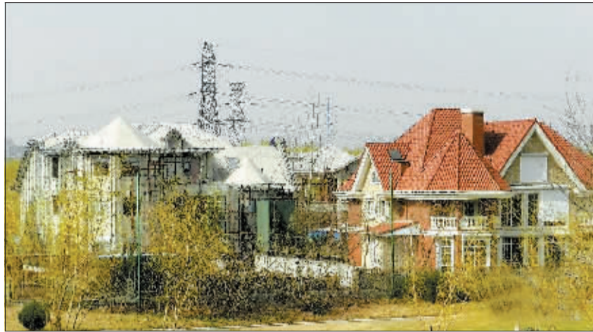
别墅群施工。四月五日,工人在北京市朝阳区的姜庄湖家园(据新华网)
