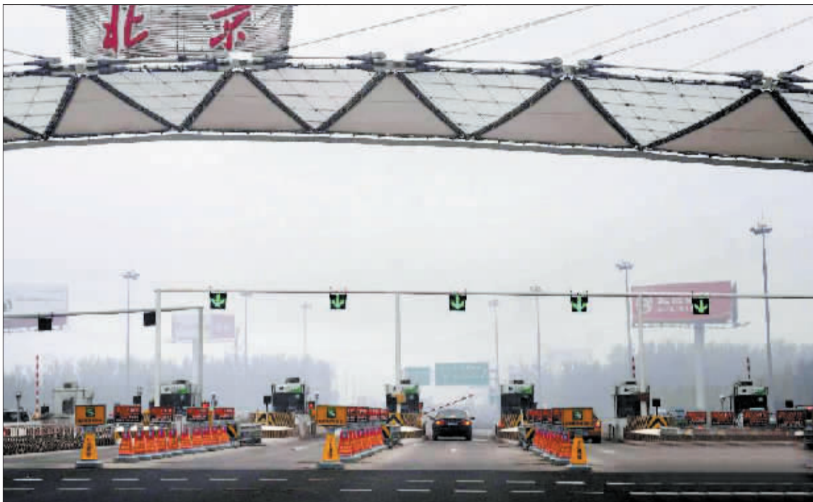
北京机场高速公路收费站。
