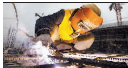
在济南市西蒋峪公共租赁住房项目建筑工地上,工人在焊接钢筋。(1月16日摄) 新华社记者 郭绪雷 摄
