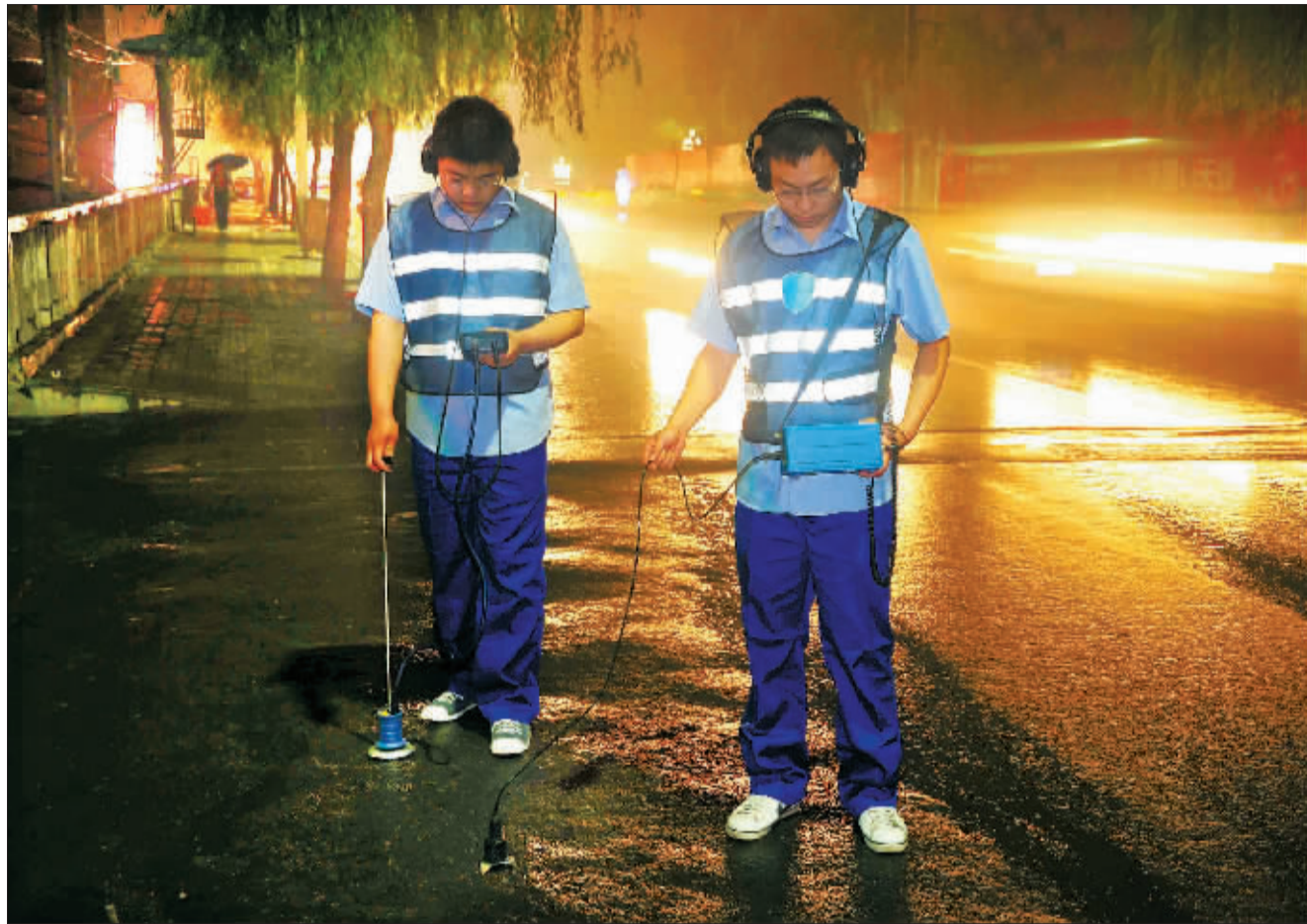
使用听漏仪检测金业路 DN300 管道。
