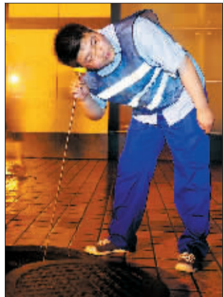
使用听音杆测供水管道。
