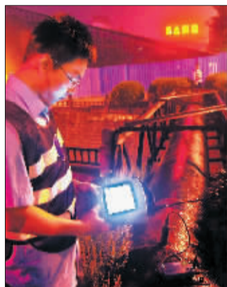
使用双探头相关仪检测管道。
