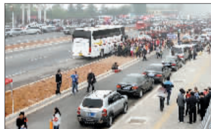
改造提升后的310国道
