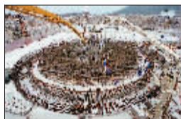
秦山核电站二期主体工程施工现场。(新华社发)
