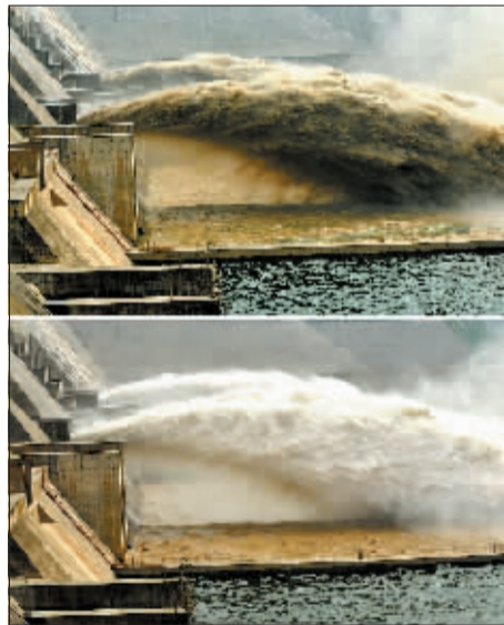
▲上图:调水调沙刚开始,洞口排出大量库区内积存泥沙,水流浑浊。下图:随着调水调沙的进行,洞口排出的水流明显变清许多。(2010年6月19日摄)
