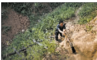
劈山凿壁,修建山路。
