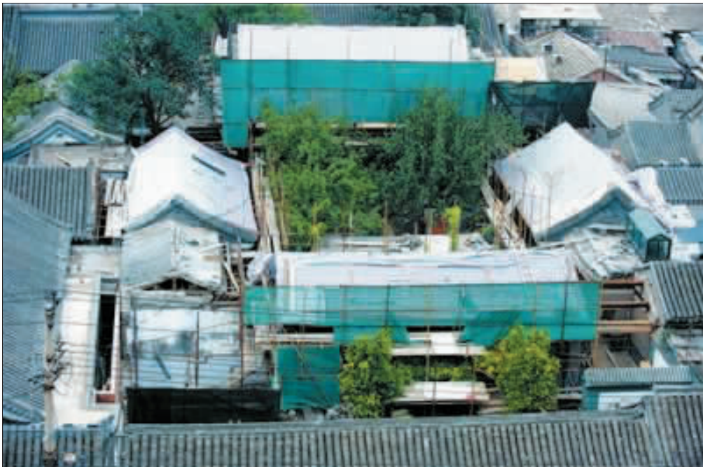
7月8日中午，史家胡同51号院内暂停施工。(本版图片均为网络图片)
