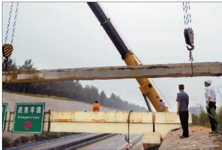
吊车正在吊起梁体。
