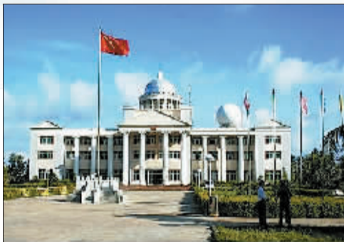
原西沙工委大楼,将成为三沙市市政府办公楼。
