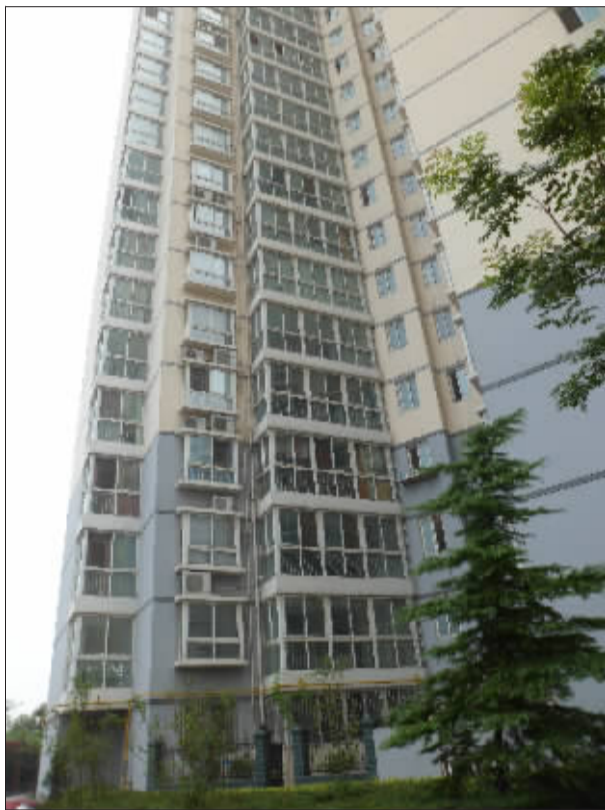
该小区空调外机只能装到飘窗上方。
