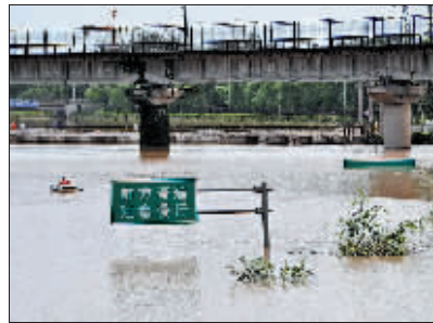
22日,京港澳高速南岗洼段被积水淹没。
