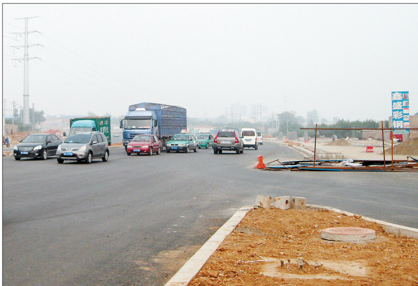
310国道国花路至定鼎路段南半幅通车。
