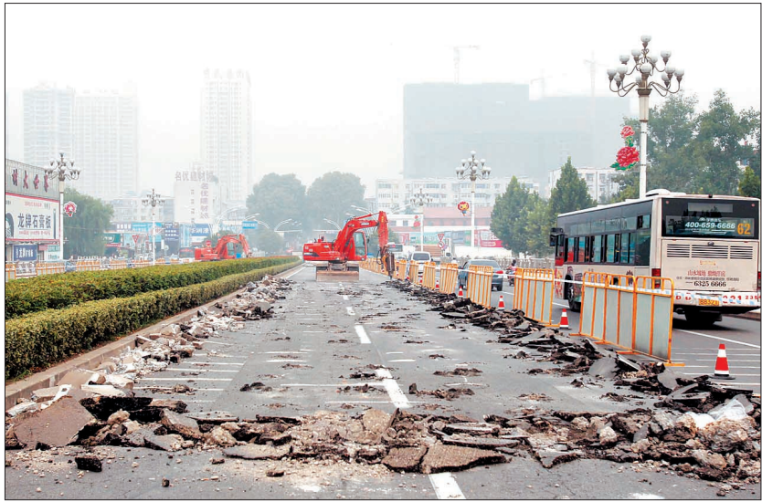
王城大道全线施工预计持续至9月上旬。
