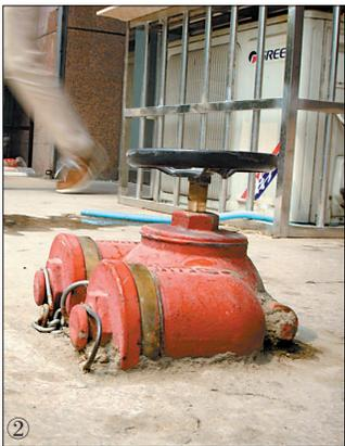
等消防设备的供水系统相连。当发生火灾时,消防车的水泵可迅速通过该接合器的接口与建筑物内的消防设备相连接,并送水加压,从而使高层建筑内的消防设备得到压力充足的水源。
