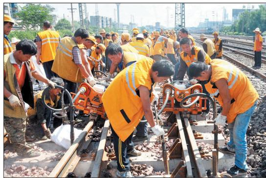
9月3日8时许,洛阳工务段300多名施工人员利用180分钟线路封锁点,更换了洛阳站内一组长37米、重70吨的整体道岔。11时10分,线路正点开通,列车以每小时5公里的速度安全通过该地段。
