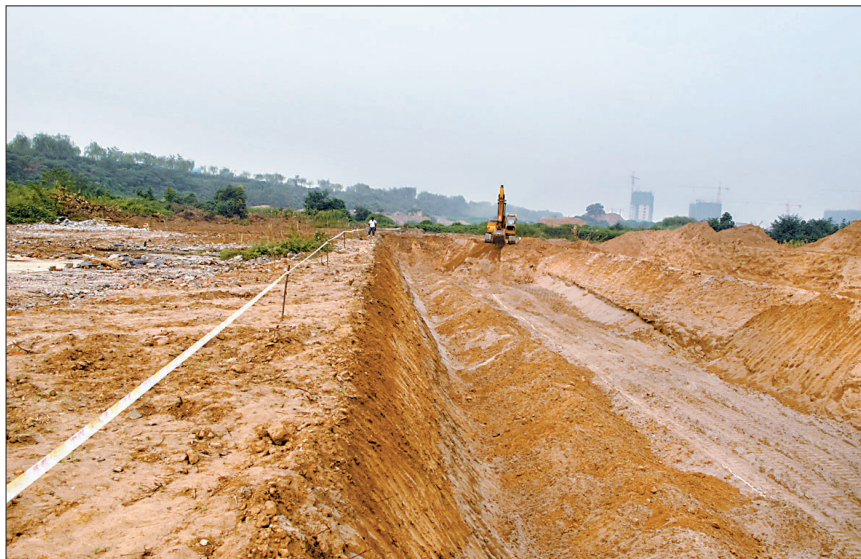
滨河北路瀍河段正在施工。
