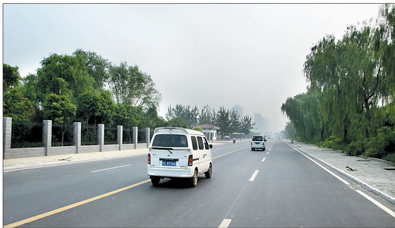
滨河北路上阳路至王城大道段已竣工通车。
