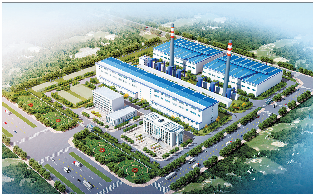
伊滨区1号热源厂厂区效果图(资料图片)
