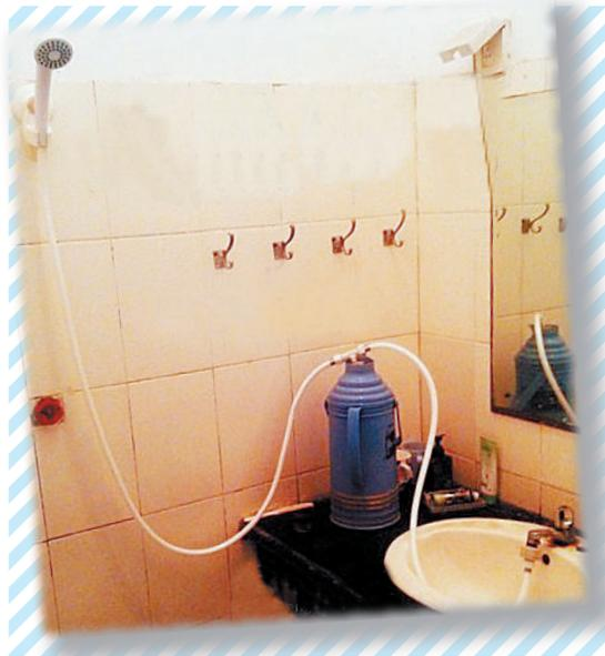
自来水龙头、装满热水的暖水瓶、T形管、淋浴喷头,你没看错,就是这几样东西就能让你舒舒服服地洗个热水澡。近日,一套被称为“宿舍洗澡神器”的装置在网上走红。
